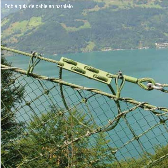
Elemento disipador de energía
