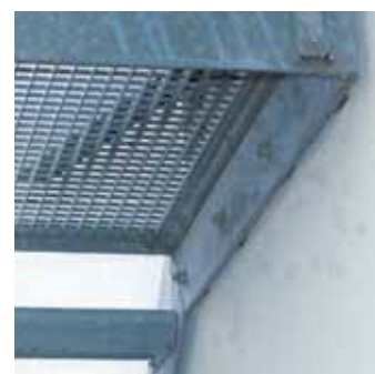
Upevnění schodiště pomocí kotev DB
