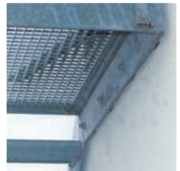
Fijación para escaleras con anclajes DB
