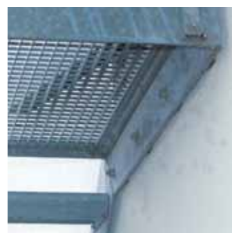
Zamocowanie schodów z zastosowaniem kotwy DB
