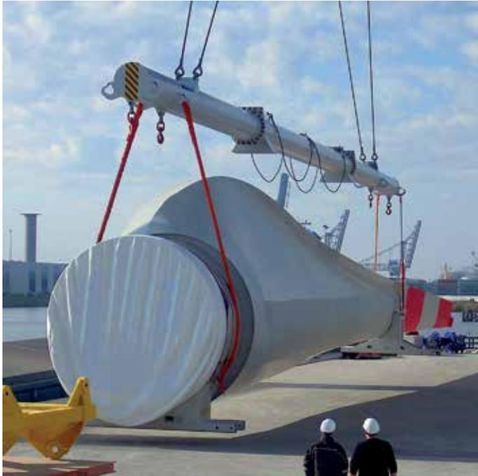
3-teilige Ausführung, verschraubt über Flanschverbindungen. Anschlagen über verschiedene Rundschlingen und auch Rundschlingen-Ketten-Kombinationen für verschiedene Rotorblätter. Aufhängung zum Kran über vier 16m Anschlagseile. Erfolgreich bestandener Lasttest mit 25% Überlast und TÜV-Zertifikat.
