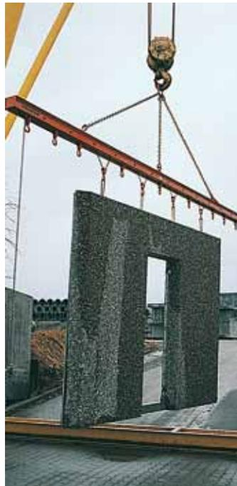
Mit **fester Aufhängung** über Kettengehänge für Lasten mit symmetrischer Lastverteilung
