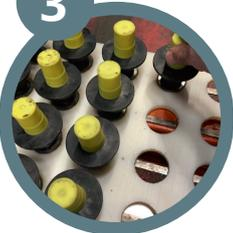
Aufstecken des Schrägstützen-Ankers MoFi
