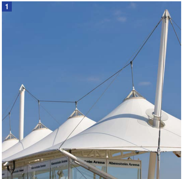
1 Membranabspannung mit Zugstäben
