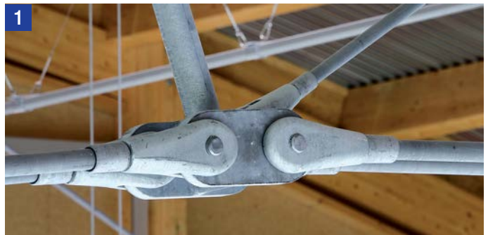
1 Knotenpunkt der Zugstabsysteme und Druckstützen
