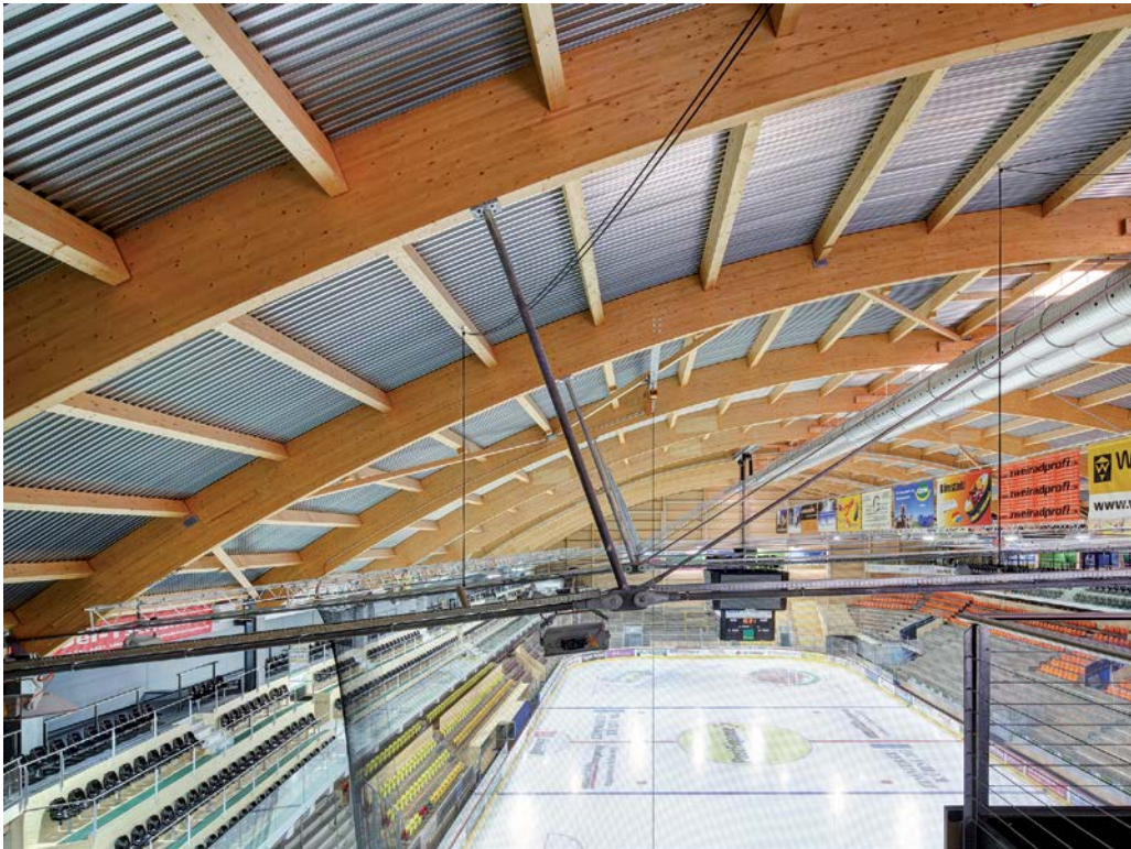
1 Knotenpunkt der Zugstabsysteme und Druckstützen
