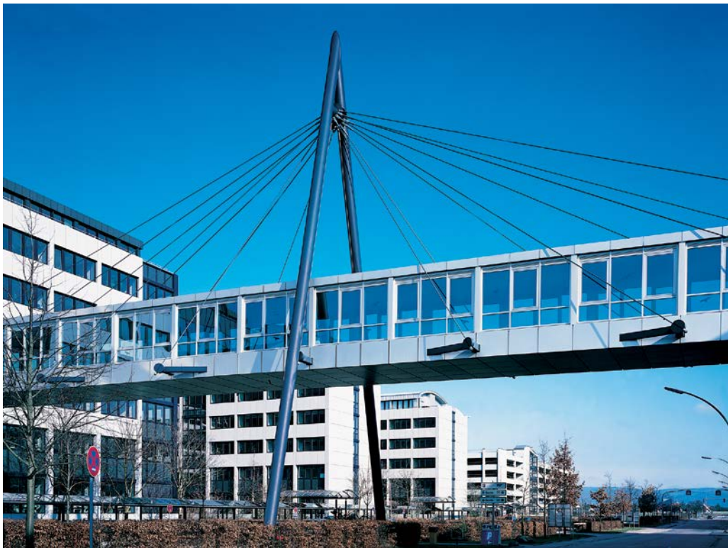
1 Offene Spiralseile verankert mit Gewindefittingen
