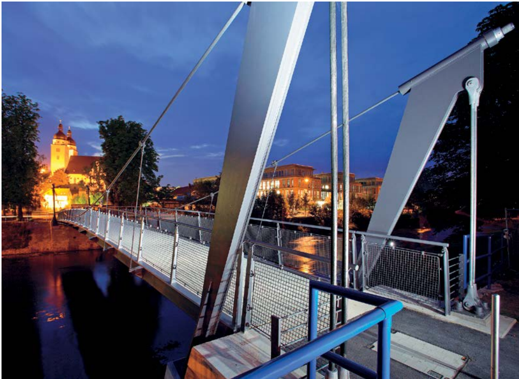
1 Verankerung Hänger- und Abspannseile
