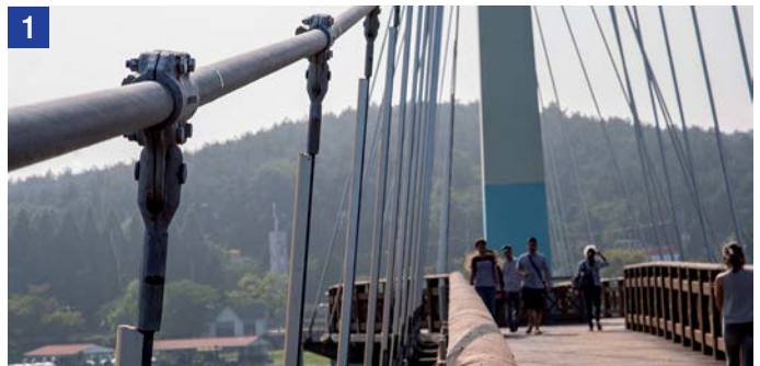
1 Tragseil mit Hängerklemmen und Hängerseilen
