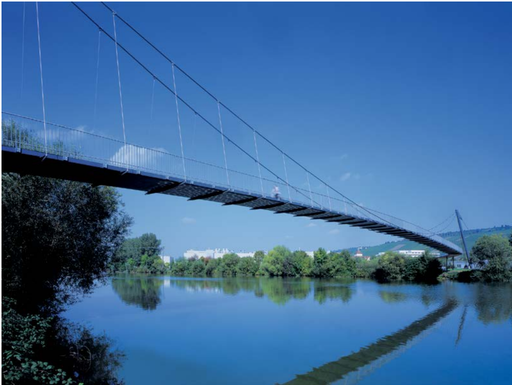
1 Asymmetrisch aufgehängte Fußgängerbrücke mit 105 m Hauptspannweite
