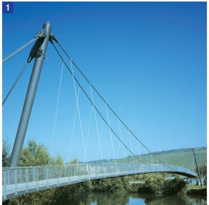
1 Asymmetrisch aufgehängte Fußgängerbrücke mit 105 m Hauptspannweite
