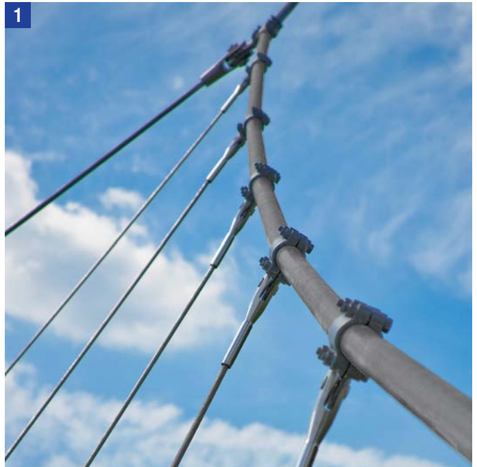
1 Hängerklemme zur Verbindung von Tragseil mit Hängerseil
