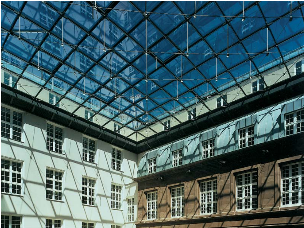
1 Edelstahl-Druckstützen mit Seilunterspannung
