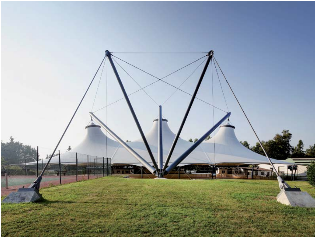
1 Anschluss der Schrägseile an den Pylon
