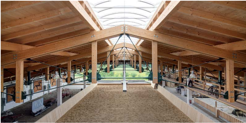
1 Knotenpunkt der Zugstabsysteme und Druckstützen
