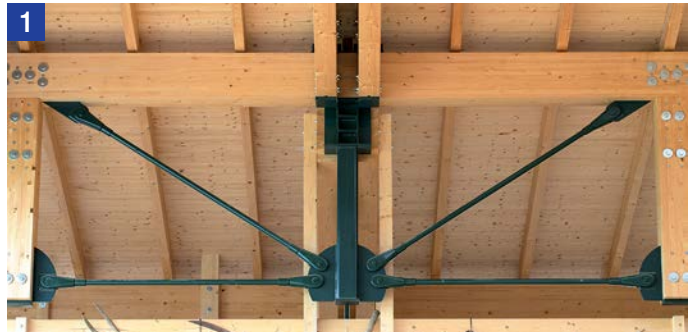
1 Knotenpunkt der Zugstabsysteme und Druckstützen
