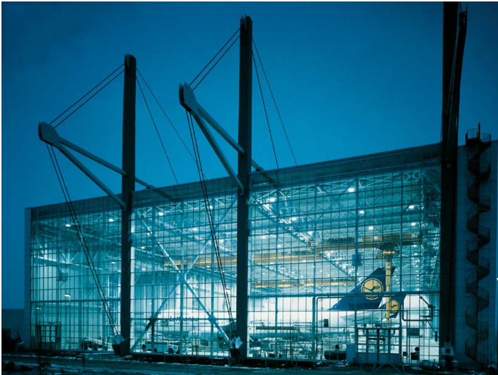
1 Abspannung an der Hallenaußenseite über Kragarm
