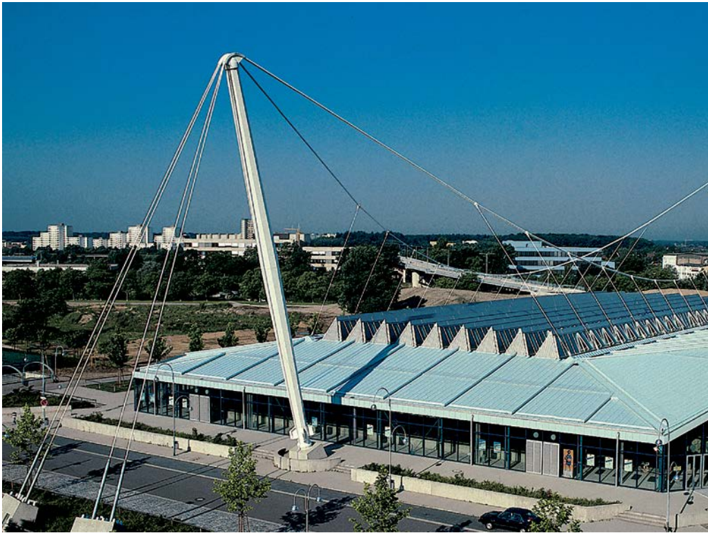
1 Pylonkopf mit Tragseilen
