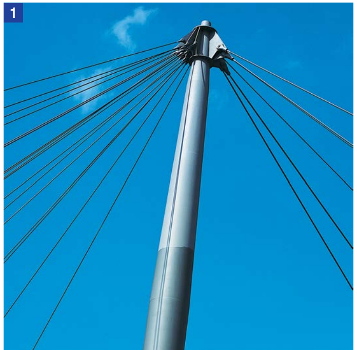
1 Pylonkopf mit Seilanschlüssen
