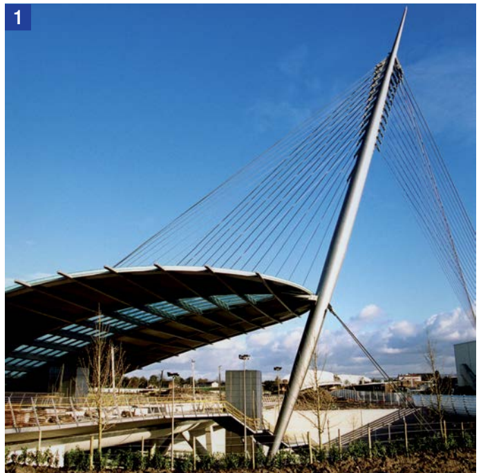
1 Pylon mit harfenförmig angeordneten Abspannseilen
