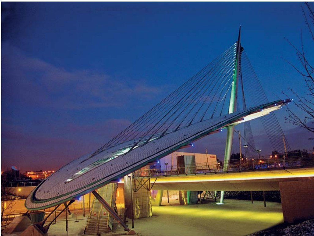
1 Pylon mit harfenförmig angeordneten Abspannseilen
