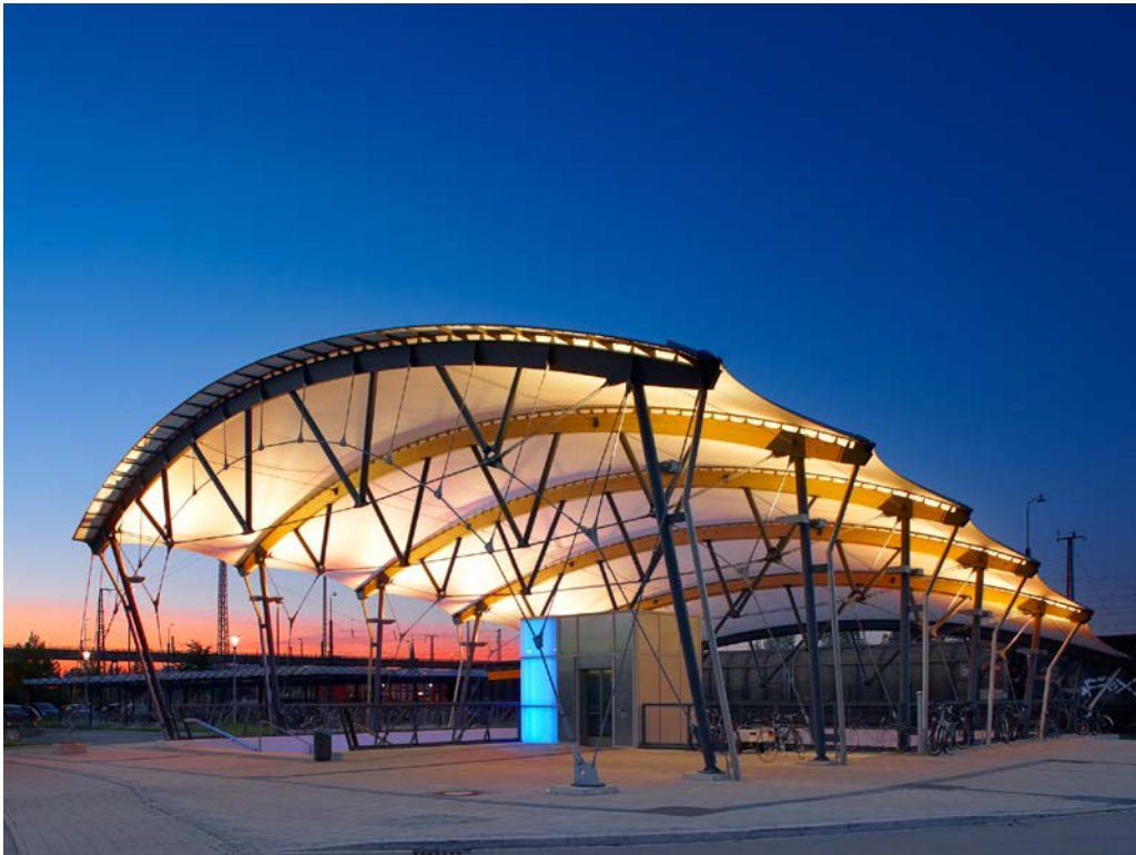
1 Seilunterspannung mit Druckstützen
