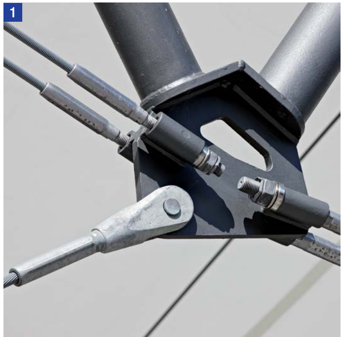
1 Seilunterspannung mit Druckstützen
