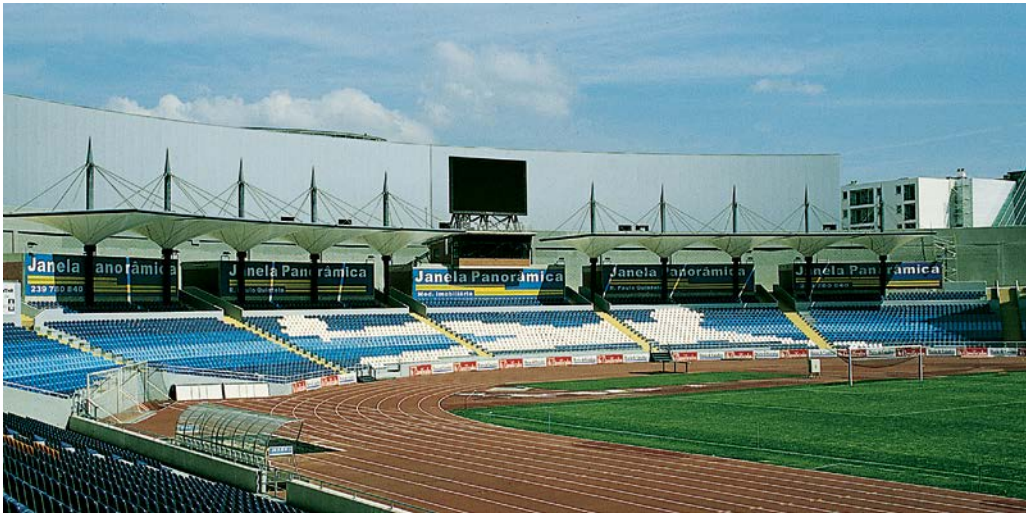
1 Abhängung der Membrandächer von den Pylonen
