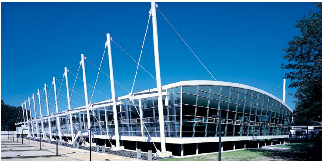
1 Pylone mit vorgespannten Zugstäben stabilisiert
