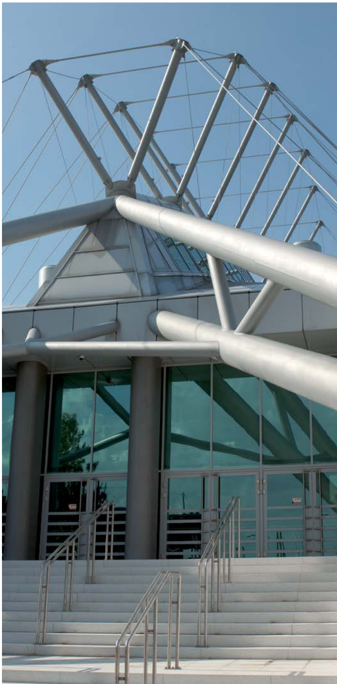
1 Außenliegendes Tragsystem mit Zugstäben
