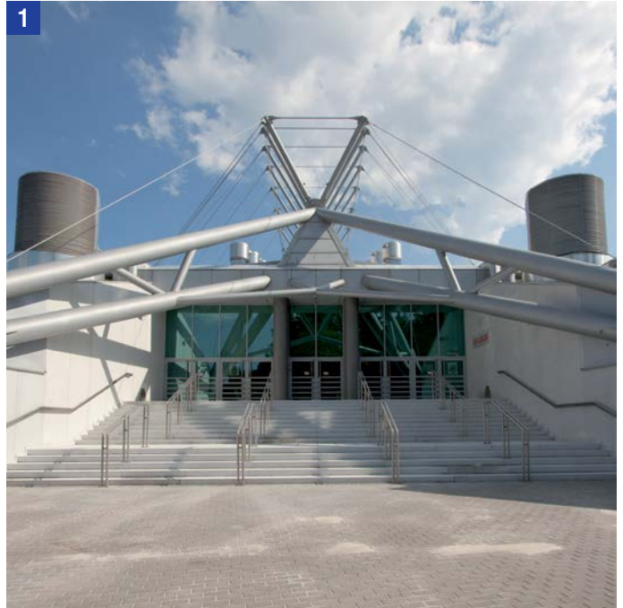
1 Außenliegendes Tragsystem mit Zugstäben
