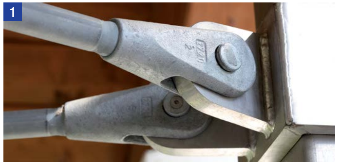
1 Anschluss Seil an bestehendes Bauwerk
