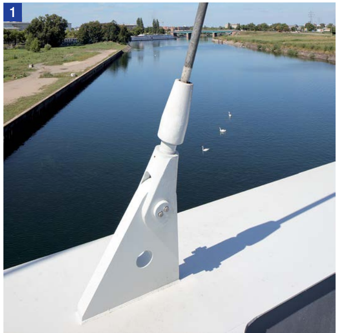
1 Anschluss Seil an Brückendeck
