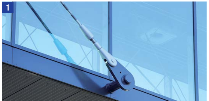
1 Anschluss Schrägseil an Brückendeck
